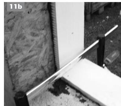
ACO Therm® Block mittels 2 Schraubzwingen (mindestens 4 Stunden) durch die Fensteröffnung an die Betonwand drücken. Zwischen ACO Therm® Block und Schraubzwinde ein Brett einlegen, um Beschädigungen der Kunststoffoberfläche zu vermeiden. Lichtschacht erst nach 12 Stunden Aushärtung des Klebers belasten.
