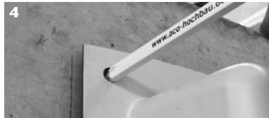
4. Bei Bedarf Bohrungen für ACO Therm® Block – Montagehilfe anzeichnen. Anschließend ACO Therm® Block von der Wand nehmen und zur Seite legen.
