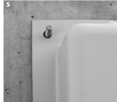
5. Bei Bedarf Bohrungen (10 mm) für die Montagehilfe in die Betonwand herstellen und Schwerlastanker einschlagen. ACO Therm® Block zur Kontrolle an Schwerlastanker anhängen. Gegebenenfalls Schwerlastanker ausrichten. ACO Therm® Block wieder von der Wand nehmen.
