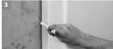
3. Außenumrisse des ACO Therm® Blocks an die Betonwand als Orientierungshilfe zeichnen.
