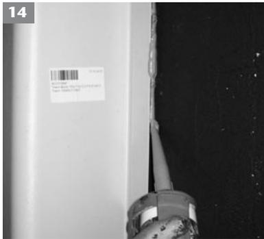
12. Beim Einsatz des ACO Therm® Blocks mit Fensterausparung nun das ACO Therm® Dämmanschlussprofil einsetzen. Hierzu die Dichtungsschnur der einbetonierten Thermzarge entfernen und das zusammengesteckte Dämmanschlussprofil in die außenseitige Zargennut einklicken.
