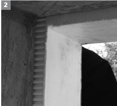
2. ACO Therm® Block vor die Thermzarge/Fensteröffnung halten und ausrichten. Es ist darauf zu achten, dass die ACO Therm® Block Fensterausparung bzw. die Fensterzarge im gleichmäßigen Abstand zur Thermzarge bzw. Betonleibung ausgerichtet wird. Bei Bedarf kann ACO Therm® Block durch die Fensteröffnung mittels Schraubzwingen fixiert werden.
