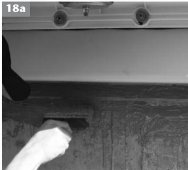
18. Nachdem der Aqua Blocker ange-trocknet ist (nach ca. 4 Stunden), 2. Abdichtungsschicht aufbringen. Hierbei die erste Abdichtungs-schicht inkl. Armierungsgewebe (Einsatz bei Bedarf) vollständig und umlaufend bestreichen.
