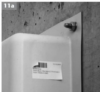
11. Bei gesetzten Schwerlastanker ACO Therm® Block einhängen und Muttern aufschrauben. ACO Therm® Block – Platte innerhalb von 8 Minuten an die Wand drücken und ausrichten. Sofern auf die Montagehilfe (Schwerlastanker) verzichtet wurde, ist ACO Therm® Block gegen Abrutschen zu sichern.
